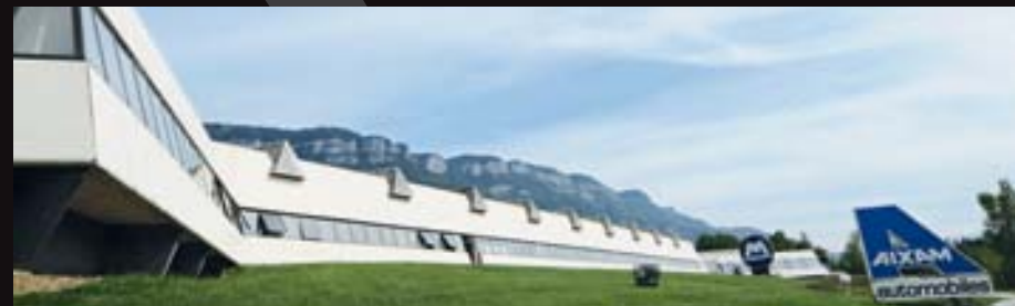
Site d'Aix Les Bains (73) - Siège social et site de production
